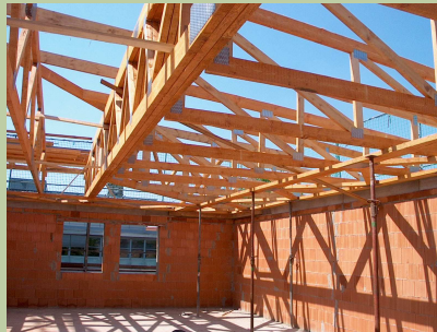
Detailansicht der Dachkonstruktion
