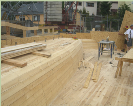
Ansicht Trog-schalung mit Aufweitung
