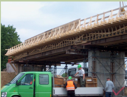
Seitenansicht der Schalung
