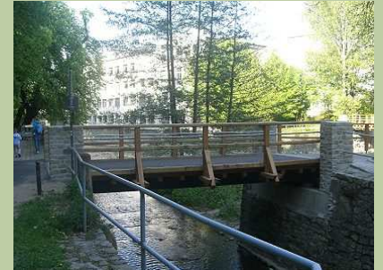
Brücke über den Kappelbach
